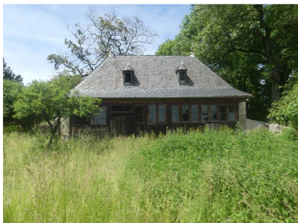
Annexe du château «le Pigeonnier»
