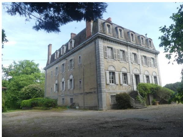
Château de Bagens, façades nord-ouest et sud-ouest
