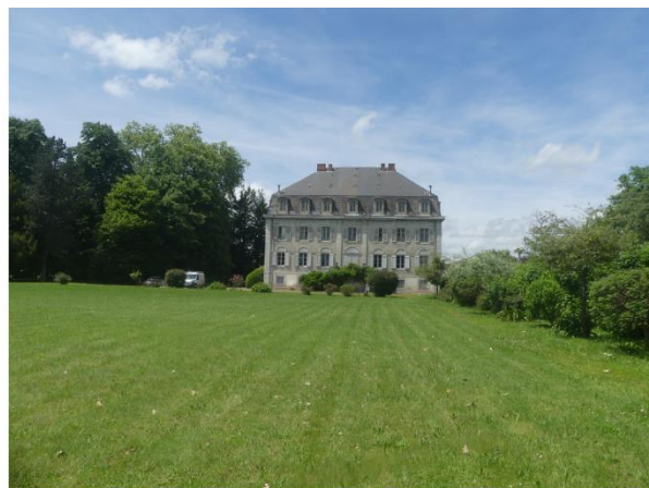
Château de Bagens, façade sud-est
