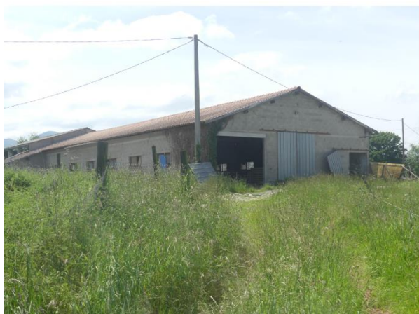
Bâtiment d'élevage au nord-ouest du château
