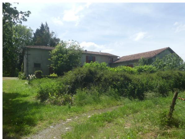
Corps de ferme au nord du château
