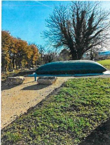
Les travaux suivent leur cours, après la mise en place de la cuve avenue Charles de Gaulle l'an passé, 1 première bâches de 60m<sup>3</sup>, installée derrière la CCM est désormais opérationnelle.
